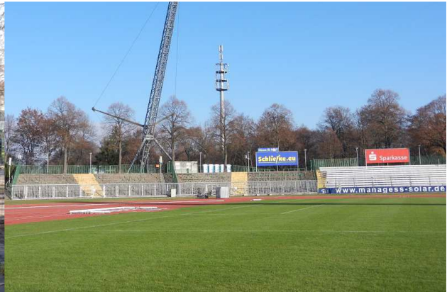
Der Gästebereich im Steigerwaldstadion.
